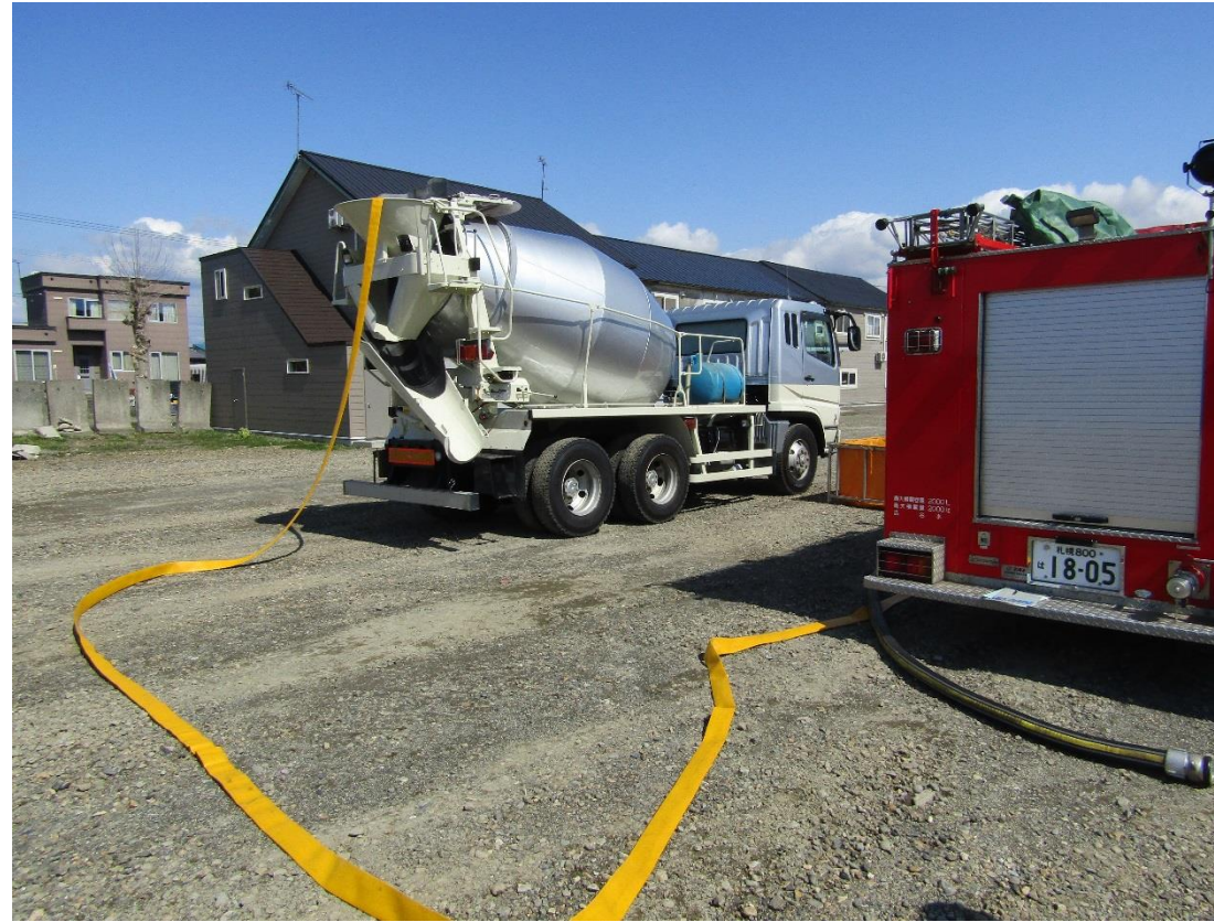
①ミキサー車へ水を供給する様子
